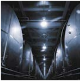
Füllstandmessung in Tanks
